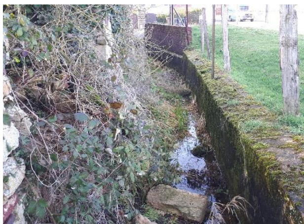
Berges artificielles en amont de la R D12
